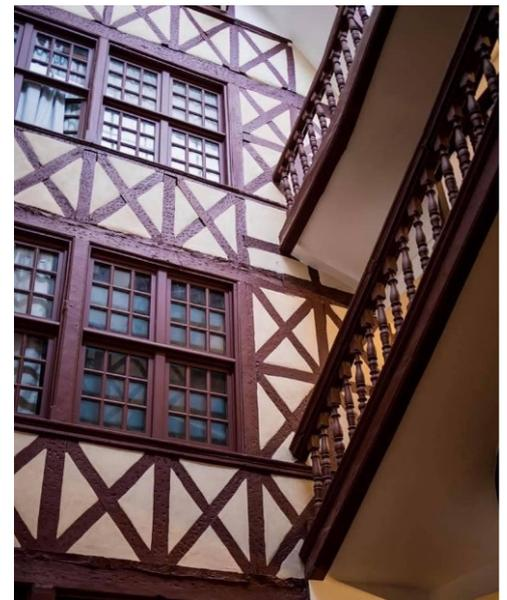
La façade a été décroûtée laissant apparaître un support en pierres sous le vieil enduit chaux. Les ouvriers ont procédé manuellement, selon la technique traditionnelle en 3 passes : application d'un gobetis et d'un corps d'enduit à base de chaux NHL 3,5 SOCLI, puis la couche de finition réalisée avec la chaux NHL 3,5 RÉNOBLANCHE et du sable roux, pour obtenir une couleur naturelle légèrement jaune.
